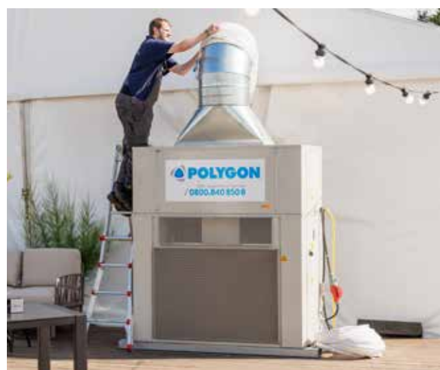
Anschluss des Lufttransportschlauchs an eines unserer Klimageräte beim Aufbau vor Ort.
