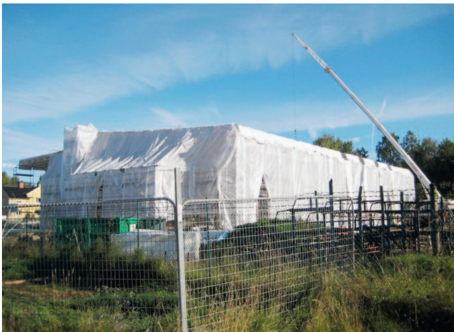
Bild 1: Fuktsäkerhetsprojekterat simhallsbygge i Tierp 2011.
