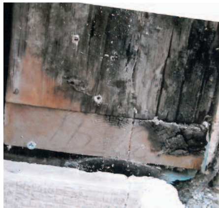
Bild 4: Fuktskada yttervägg.
