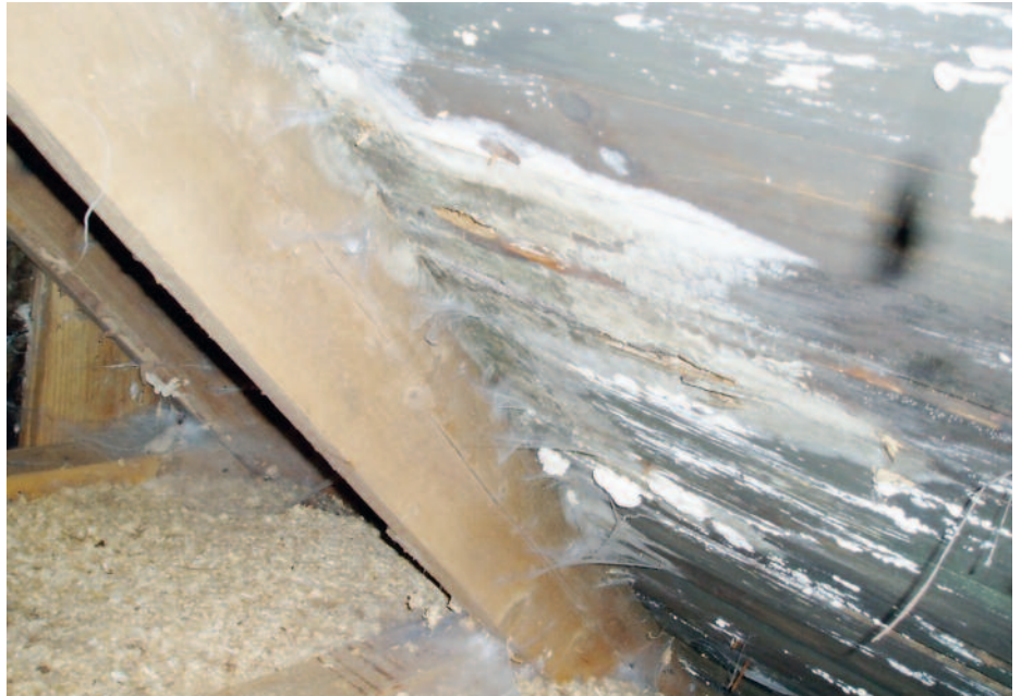
Fuktskada, uteluftventilerad vind.
