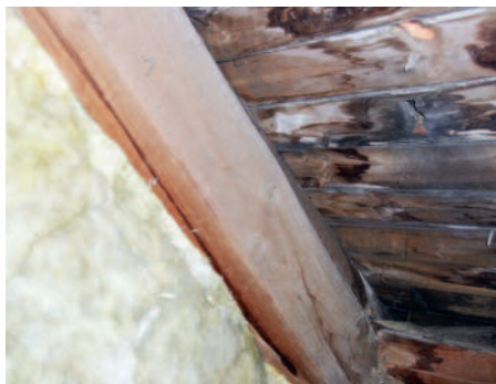
Fuktskador och träskyddsbehandlat trä bakom kontorsväggarna.
