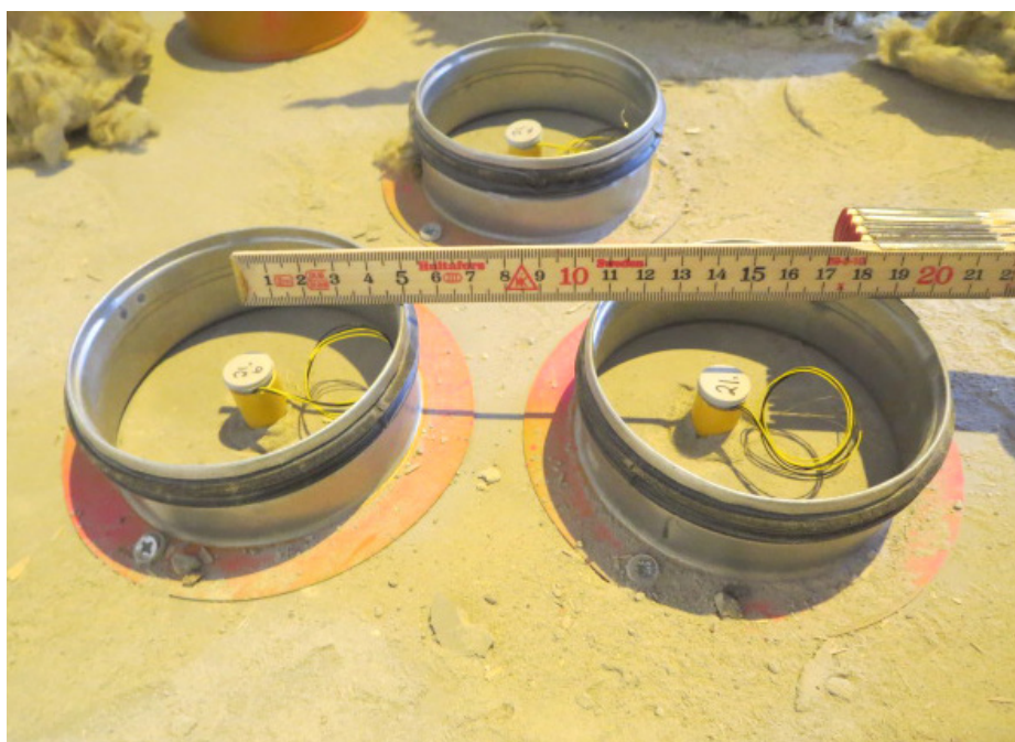
Figur 6 Montage av trippelpunkt för exaktare bestämning kan användas vid osäkerheter, Stålrिंगarna sitter som påkörningsskydd för mätpunkten.
