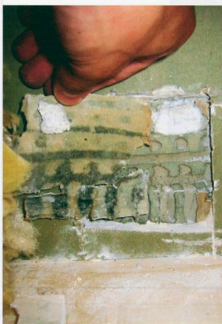
Bild 1: Skadad kartonggips.
