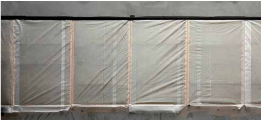
Figur 8 Prefabricerad provisorisk tätning som kan flyttas med efterhand som stommen går upp och fönster sätts i möjliggör lite bättre isolerade lösningar eftersom de återanvänds.
