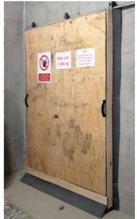
Provisoriska dörrar till trapphusschakt för att undvika skorstensverkan.
