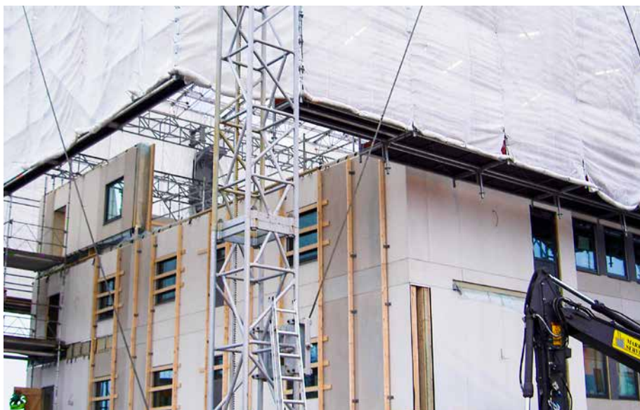
Bild 7. Prefabricerade planelement som monteras under heltäckande väderskydd med invändig travers.
