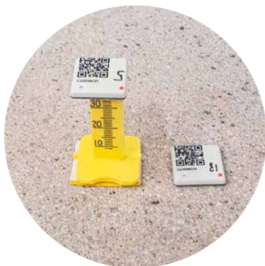
Figur 2. Polygon D21 – fuktsensor inför ingjutning på olika nivåer i avjämning.
